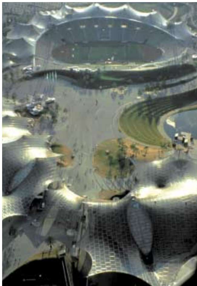
Flächentragwerksbau, Olympiastadion München, 1972 nach dem Vorbild von Spinnweben
